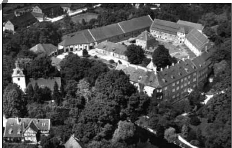
Bild 4: Luftbild aus Richtung Süden
